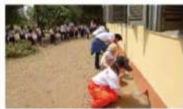
国際支援・文化教育「カンボジア小学校の外壁修復作業」
