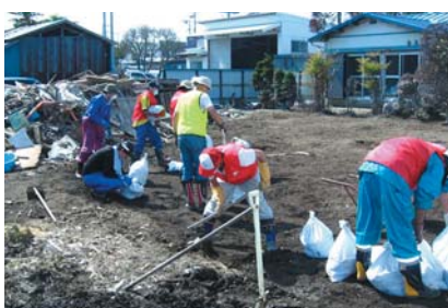
道路の溝に詰まった瓦礫や泥を撤去。
